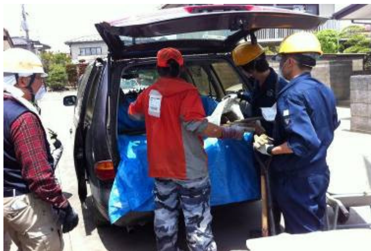
作業道具を車両から降ろしている所(個人宅前)
