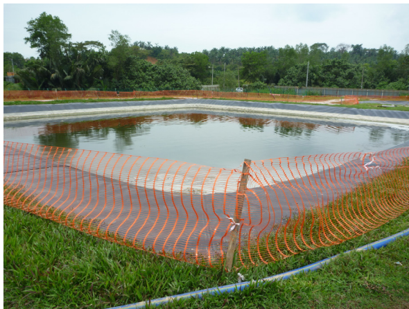
ごみから出る污水をくみ上げて溜めている。きれいにしてから川へ流す。
