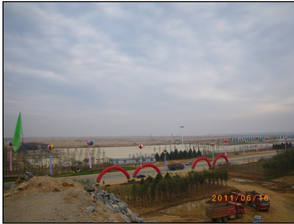
「モデル園區では急ピッチで埋め立て作業中」
