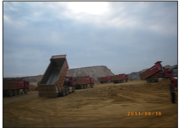
「100 台くらいのダンプ車がピストンで作業中。」
